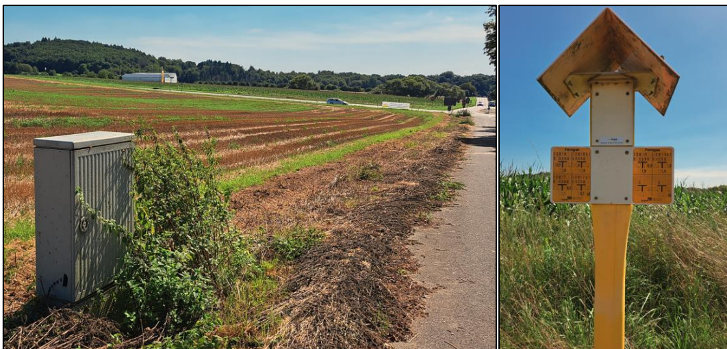
Vorhandene Infrastrukturen mit Abstimmungserfordernissen (eigene Aufnahmen 7.23)
